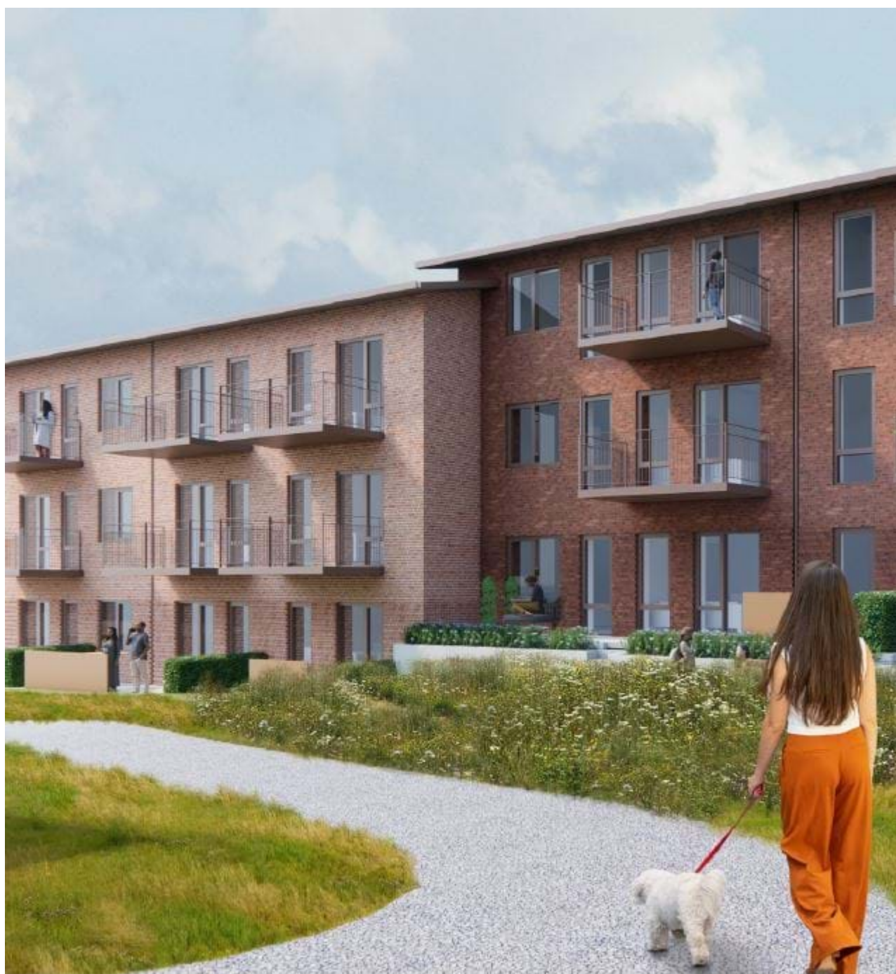
Eksempel på både vertikal og horisontal forskydning i facadelinjen mellem to boligenheder.
